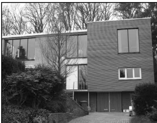
aanbouw aan de Bachlaan
