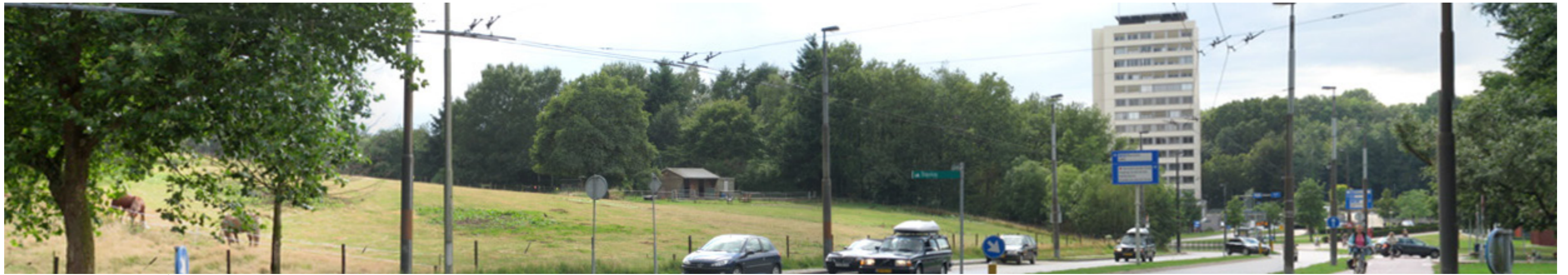
Huidige situatie / ranke toren steekt boven boomkronen uit
